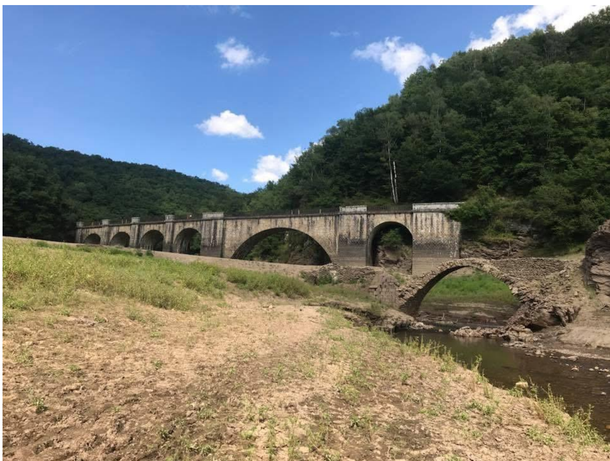
Pont du Rouffet viaduc de la Bertrande-Juillet 2018
